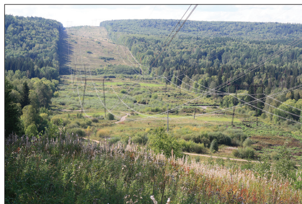
Рис. 1. Просека под две линии ЛЭП-500.
